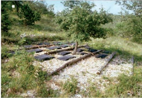
Fig. 54 - Pianello pacciamato a scacchiera usando sacchi di rete riempiti con argilla espansa; l'erosione del terreno è stata limitata con pali di legno posti trasversalmente
