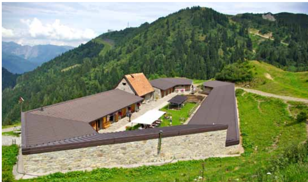
L'originale architettura di malga Pozof.
