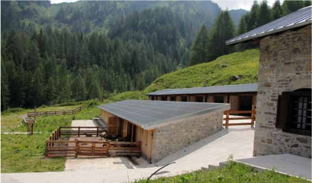
Stalle di malga Monteriù, recentemente ristrutturate.
