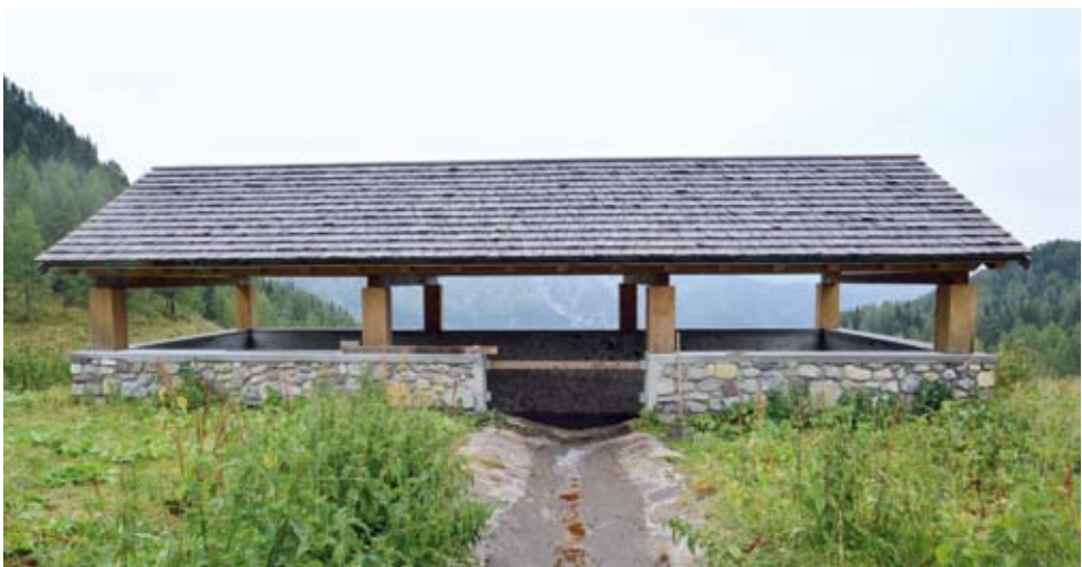
Geeignete oberirdische Sammelvorrichtung für Tierausscheidungen
