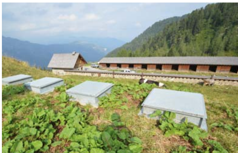
Serbatoi interrati adeguati di accumulo dell'acqua
