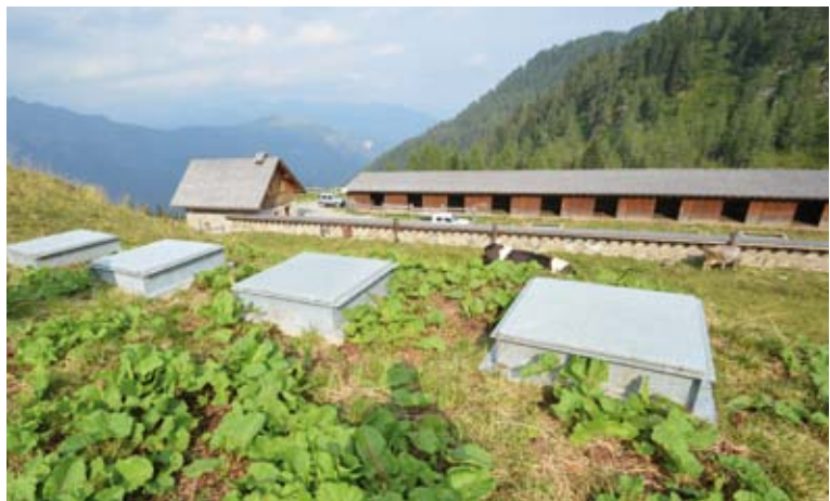
Geeignete unterirdische Wassertanks
