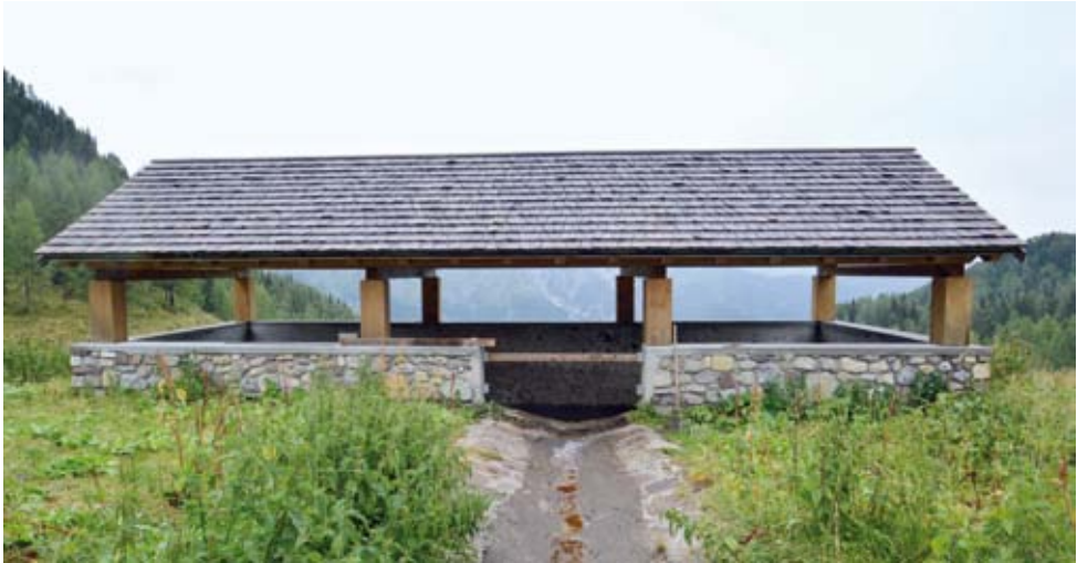
Struttura di raccolta deiezioni fuori terra idonea
