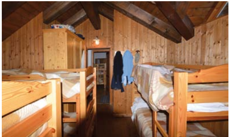
Richtig behandelte Holzteile und -flächen in Innenräumen
